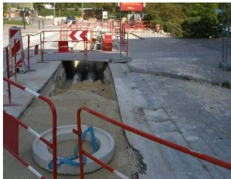
Photo d'un passage sur tôle pour accès à un parking
