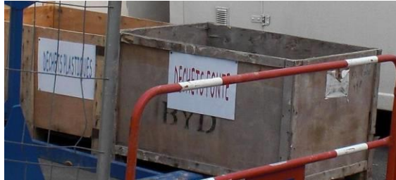
Photo type de caisse de tri des déchets sur chantier
